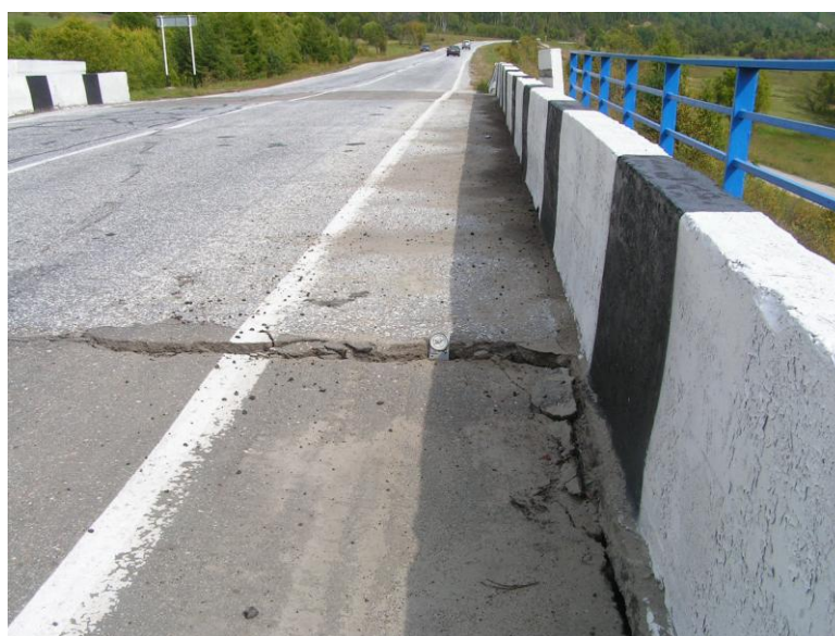
Рисунок 6. Сейсмогравитационная трещина в насыпи автодороги Култук–Монды (а), вертикальное смещение полотна автодороги Култук–Монды (мост через р.Култучная) (б).
